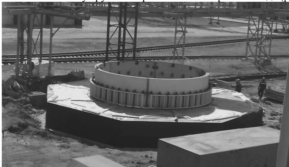
Рисунок 4 – Общий вид фундамента на этапе строительства в сентябре 2017 г.
