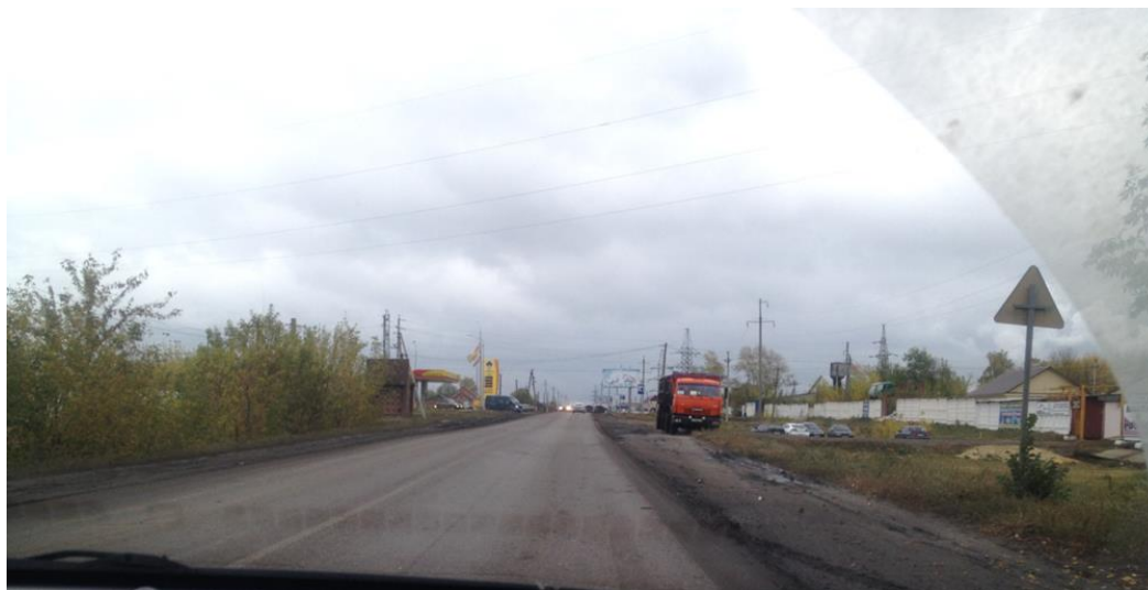
Рис. 1. Участок автодороги общего пользования ПК 0+50 по ул. Гражданская- Производственная
