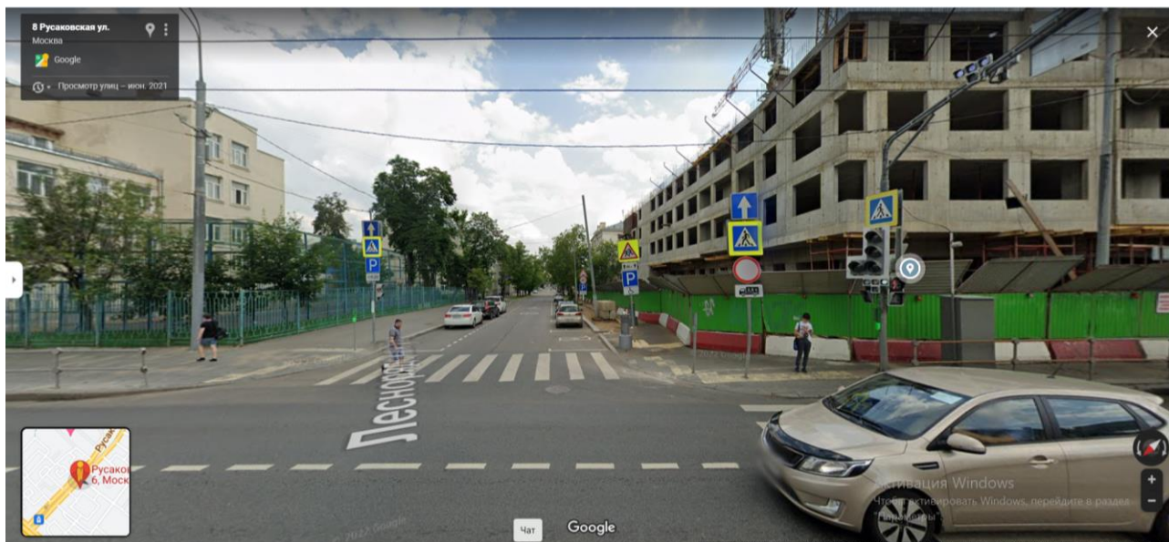
Рис. 1. Строительства жилого дома по ул. Русаковская, г. Москва
