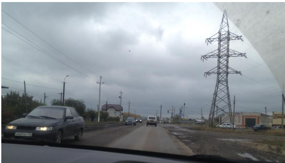
Рис.3. Участок автодороги общего пользования ПК 8+30 по ул. Гражданская-Производственная
