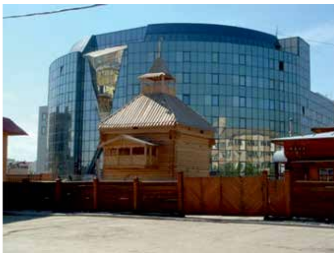
Рис. 11. Башня Якутского острога после реставрации
