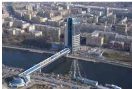
Рис. 5. Мост «Багратион» и «Башня 2000»
