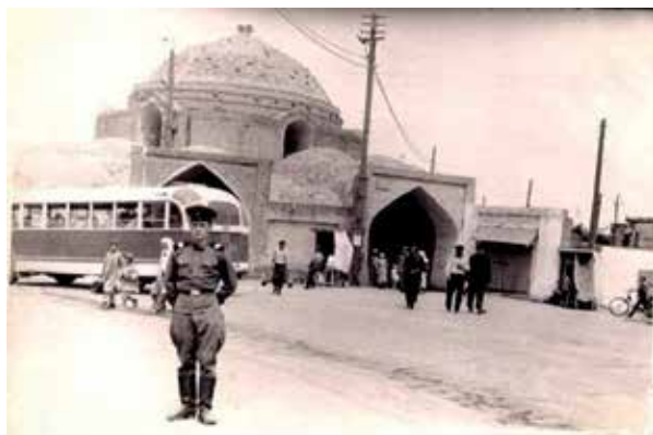
Рис. 2. Общий вид купольного торгового центра «Токи Телпакфурушон» с востока
