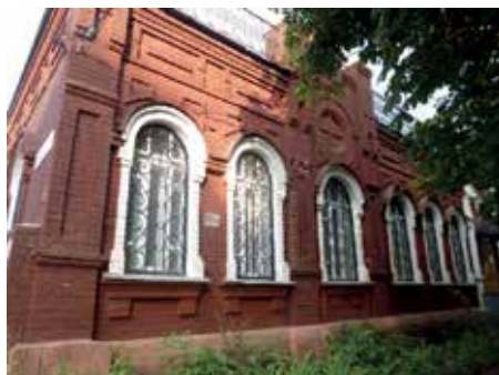
Рис. 4. Здание дворянского поземельного банка
