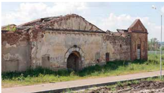
Рис. 6. В центре — главный вход бывшего мокшанского тюремного замка, справа — тюремная церковь Тихона Задонского.
