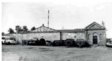
Вид на юго-запад
