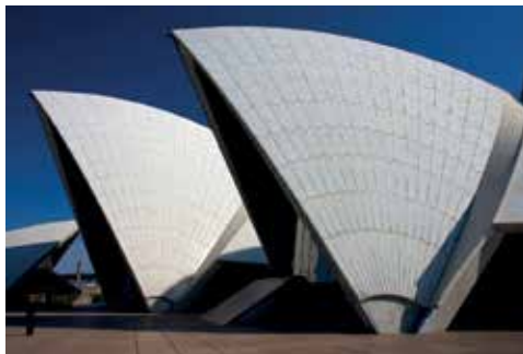
Рис. 4. Кровля Сиднейского оперного театра
